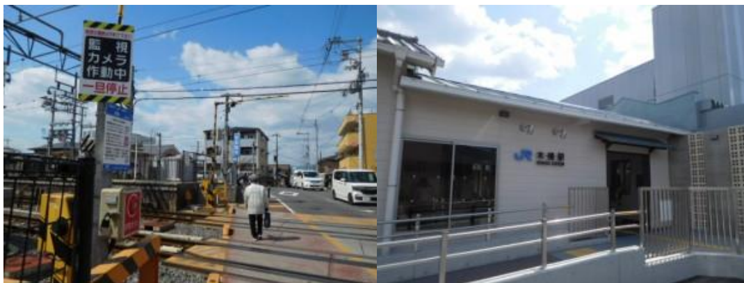
※木幡踏切、木幡駅
